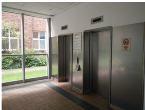
Aufzüge im Gebäude Miraustr. 54.
